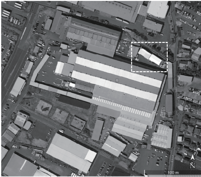
S3 社の敷地全景。点線で囲った場所がアッセンブル管理された建材の置き場。
