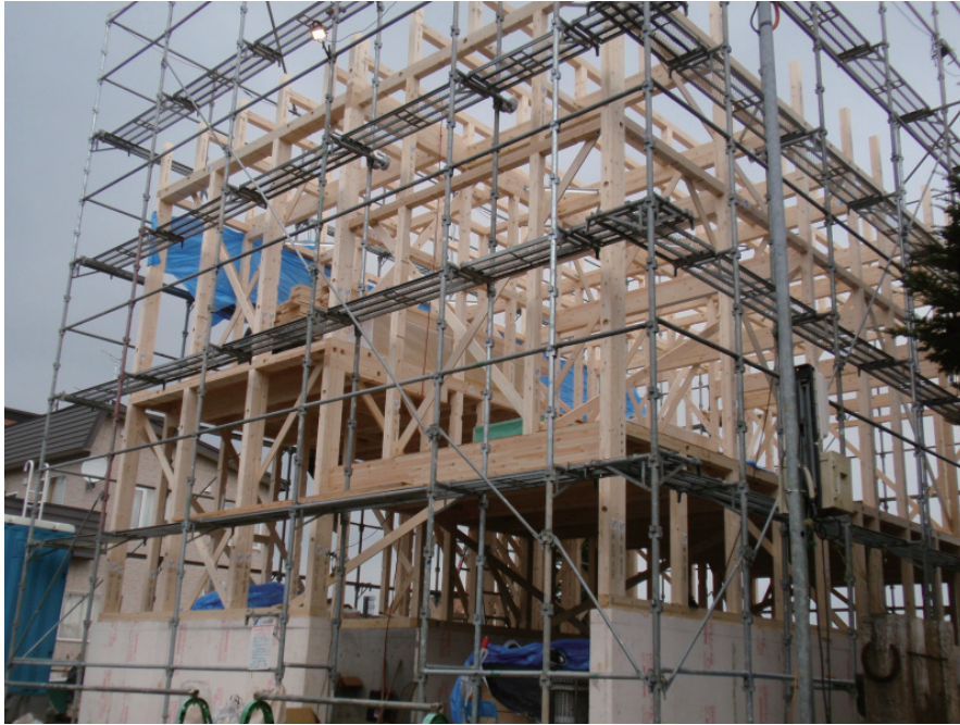
写真2 (1) 2 組み上がった構造
