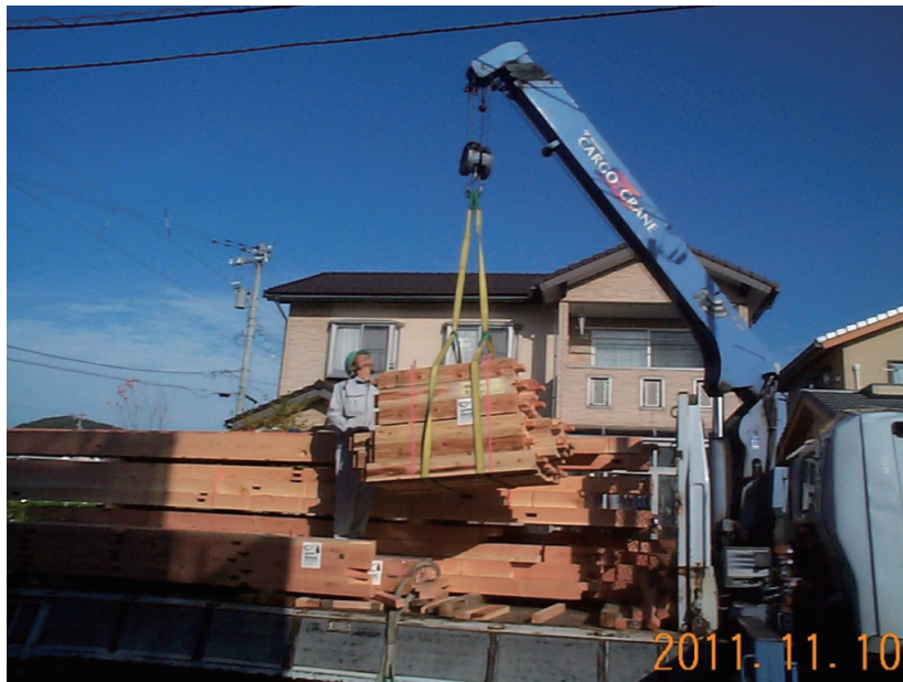
写真 2 (7) 1 プレカット部材の表示
